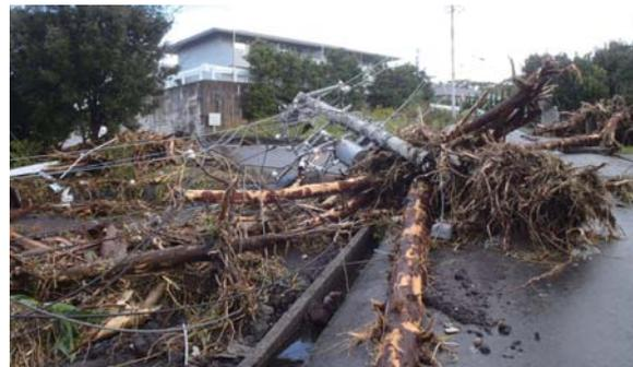
土砂・倒木落下による電柱倒壊（10月16日）
