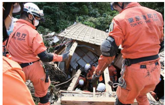
倒壊した家屋での救助・捜索活動（東京消防庁提供）
