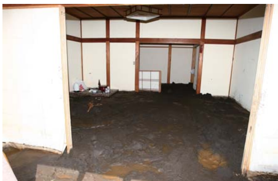
室内を埋め尽くした泥流（東京消防庁提供）
