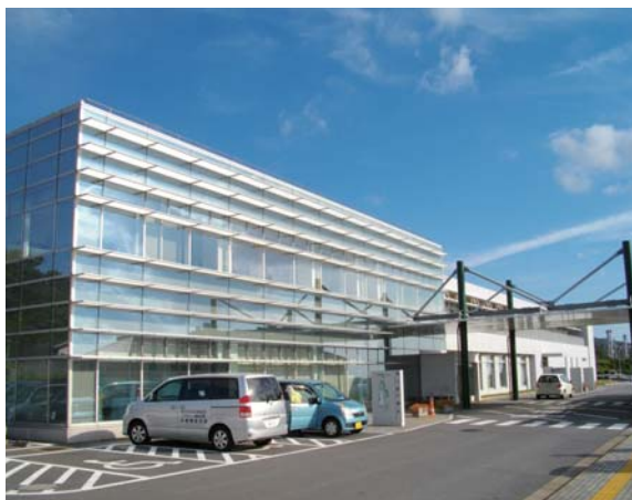
大島医療センター外観（大島医療センター提供）
