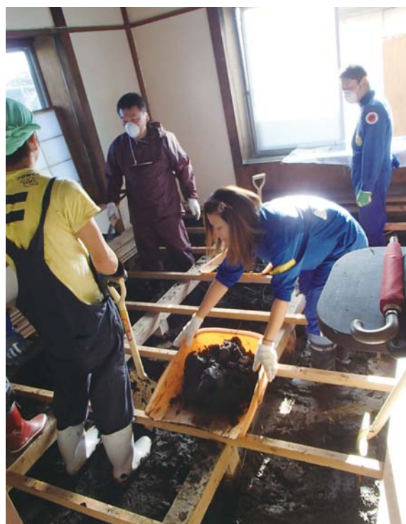
家屋内の土泥のかき出し作業（大島社会福祉協議会提供）
