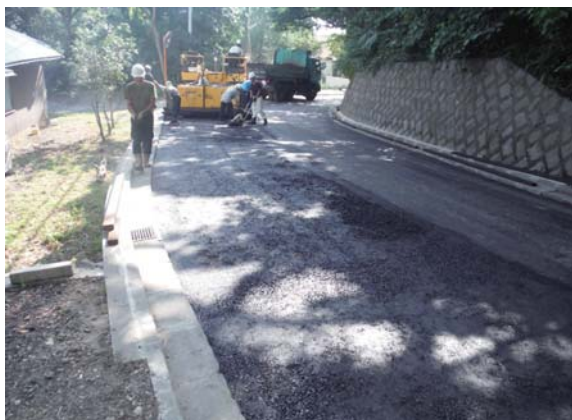
町道復旧の様子
