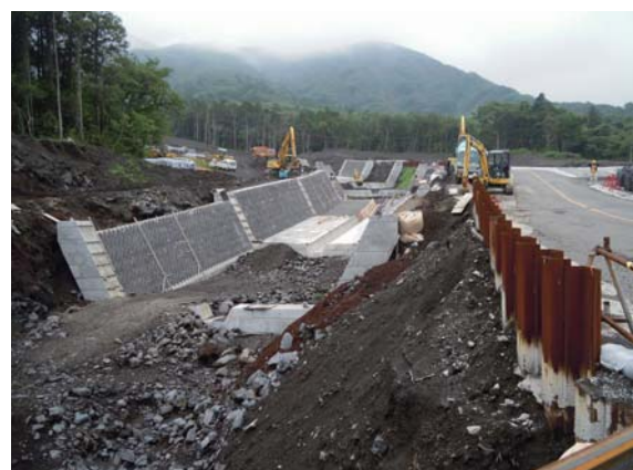
大金沢導流堤工事（平成27年7月）
