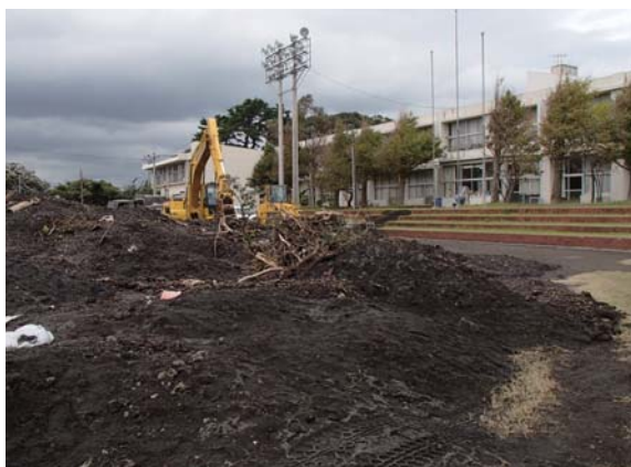
災害廃棄物の仮置場となったつばき小学校校庭
