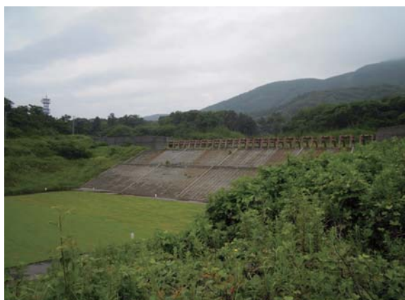
土砂・流木撤去後の大金沢堆積工（平成27年7月）
