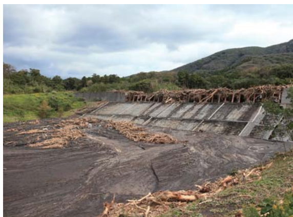
大金沢堆積工（10月18日）（東京消防庁提供）
