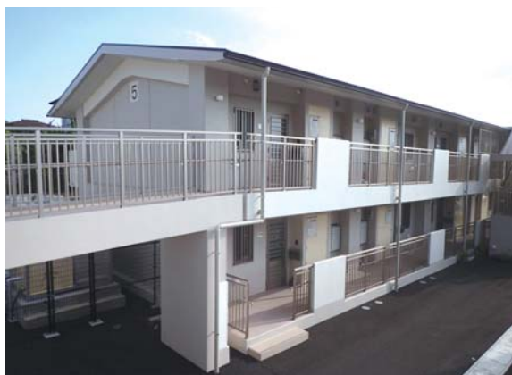
公営住宅（元町地区）
