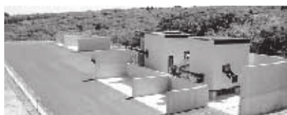
大島リサイクルセンター全景 コンクリート・アスファルト廃材再利用施設
