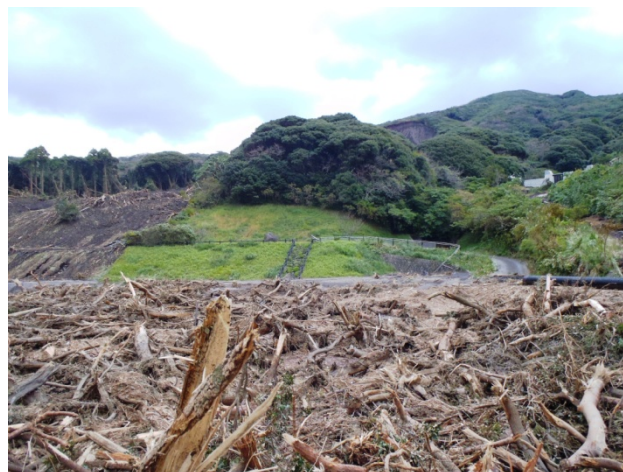
長沢ダムに溜まった流木
