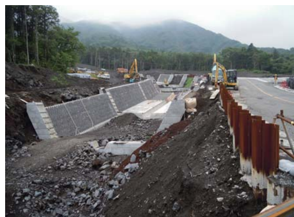
大金沢導流堤工事（平成 27 年 7 月）
