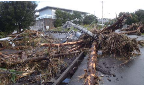
土砂・倒木流下による電柱倒壊（10月16日） （気象庁伊豆大島火山防災連絡事務所提供）
