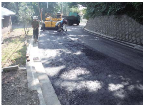
町道復旧の様子
