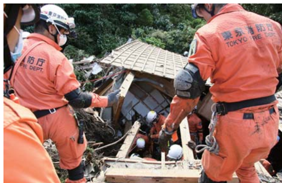
倒壊した家屋での救助・搜索活動（東京消防庁提供）
