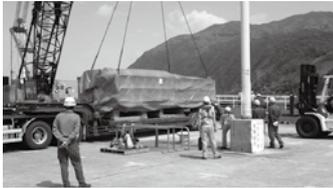
↑八丈島内燃力発電所2号発電設備水切り作業と搬入作業
