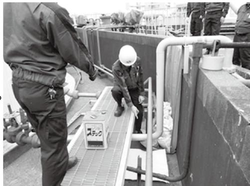
↑燃料タンク防油堤亀裂箇所への漏油処置
