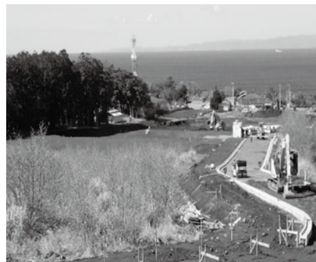
3月現在の建設予定地 (造成等工事中)
