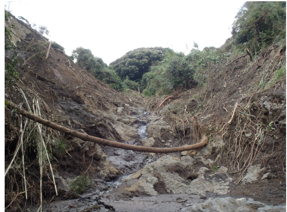
河床状況。一部露岩しているが、軟弱な土砂が堆積
