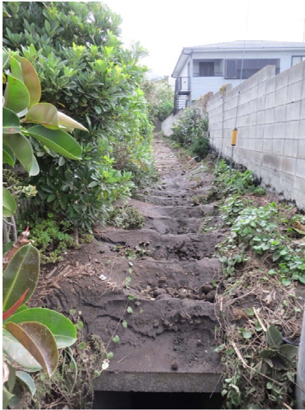
下流に流出した土砂状況
