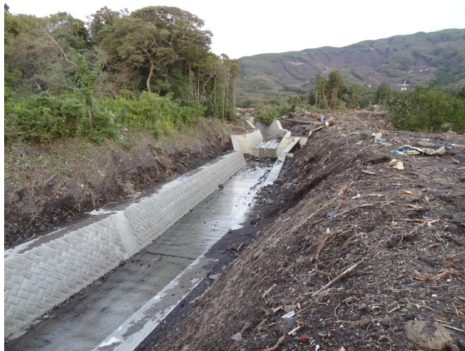
流路工の状況
