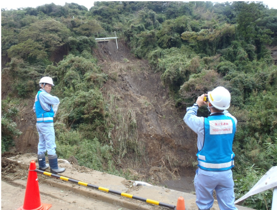
町道下の崩壊。崩壊高約H=68.0m、幅W=20.0m
