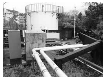
燃料配管二重化完了状況
