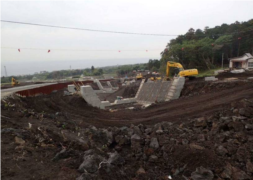
撮影方向 ② 上流～下流
