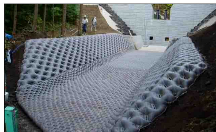
水路工（施工事例）
