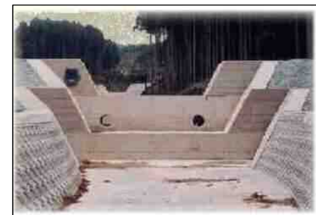
床固工（施工事例）
