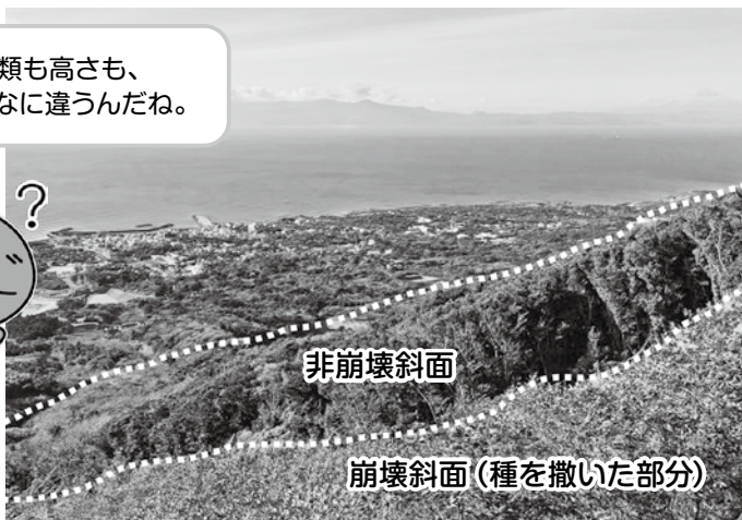
【写真1: 崩壊斜面と非崩壊斜面(2023.12.6撮影)】
