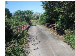
八重沢2号橋 橋長 12.6m
