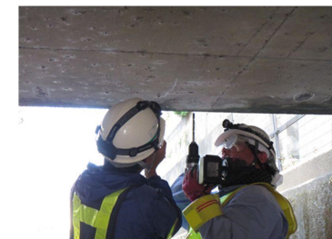
〔図 ドリル法 作業状況例〕
