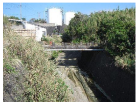
五輪の橋 1963 (S38) 年 58年経過
