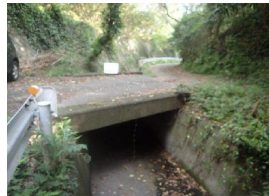
RC橋（ゴーノー2号橋）
