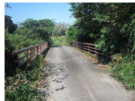
八重沢2号橋 2002 (H14) 年 19年経過
