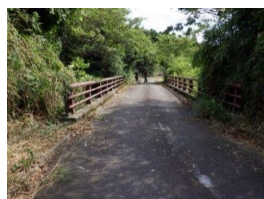
八重沢橋1号橋
