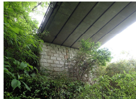
PC橋（八重沢1号橋）
