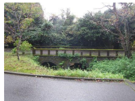
その他（石橋）（中之橋）
