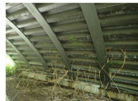
鋼橋（根古沢8号橋）
