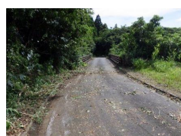
八重沢橋2号橋
