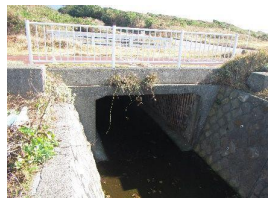
ボックスカルバート（万立橋）
