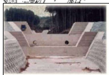
床固工 (施工事例)
