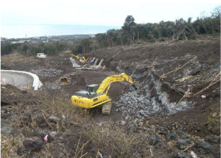
撮影方向 ② 導流堤 上流～下流
