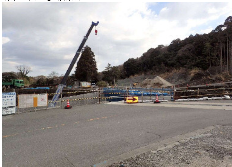
撮影方向 ① 橋梁部
