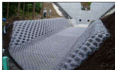
水路工 (施工事例)
