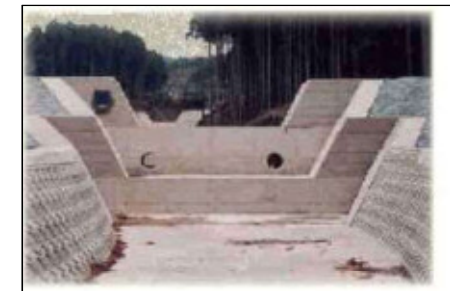
床固工（施工事例）
