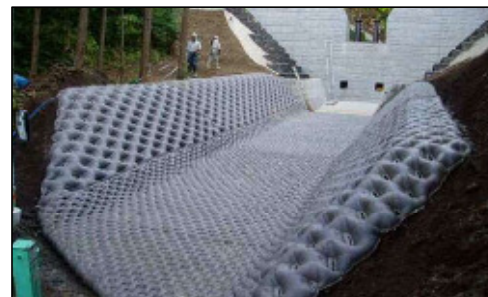
水路工（施工事例）
