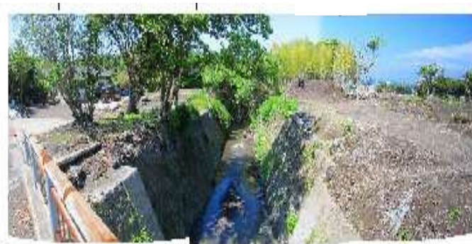
大金砂橋下流 22
