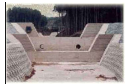
床固工 (施工事例)
