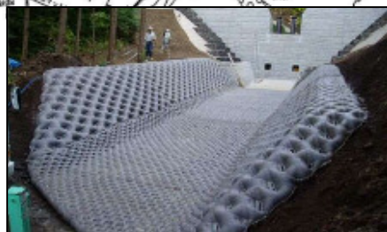
水路工 (施工事例)
