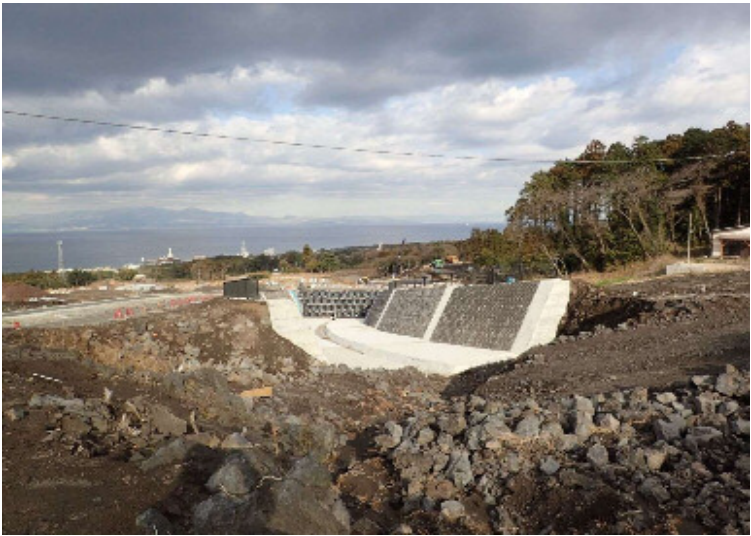
撮影方向 ② 上流～下流
