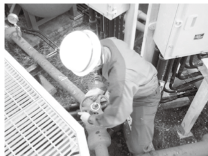
点検実施状況
