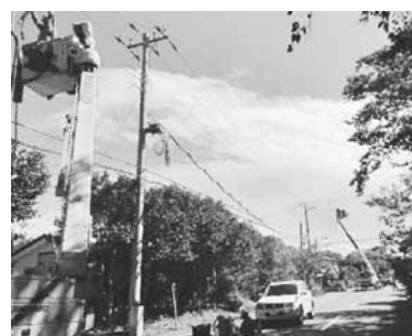
無停電工事実施状況
