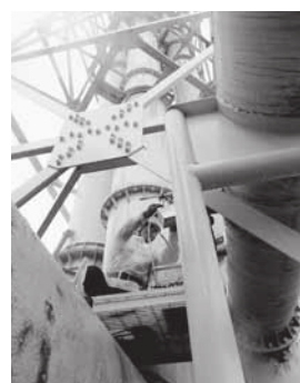
2号機関点検状況
