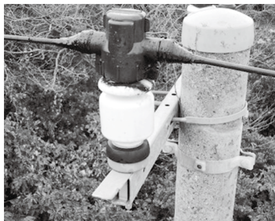
放電クランプによる放電後の状態
