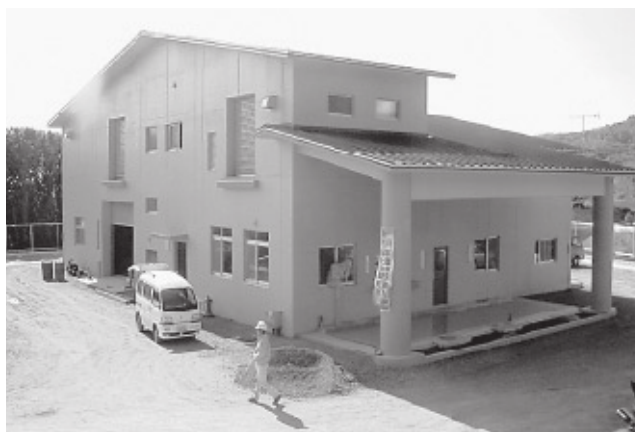
管理棟（水処理施設）
