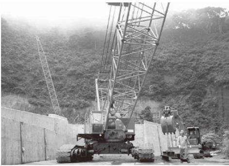
橋桁を架設する100t吊クレーン
