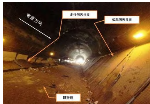
〔写真 笹子トンネル天井板の落下状況〕 (国土交通省HP トンネル天井板の落下事故に関する調査・検討委員会より)
